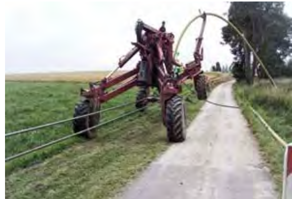
Abb. 24 – Neuverlegung (Pflügen) Verlegevorgang
