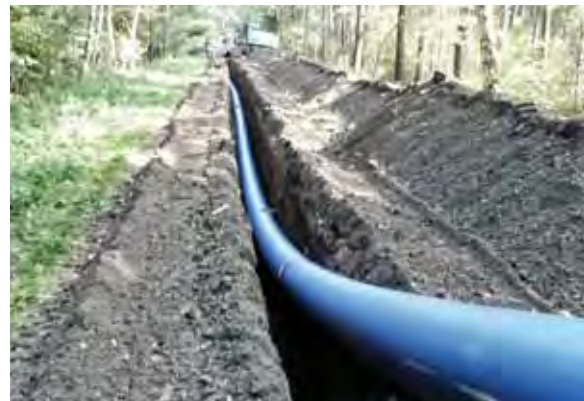
Abb. 28 – Neuverlegung (Fräsen): schmale Rohrtrassen
