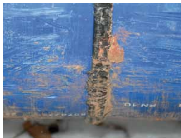
Abb. 32 – Neuverlegung (Berstlining): Höchste Anforderungen an das Neurohr
