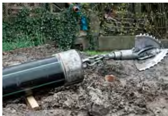
Abb. 30 – Neuverlegung (Horizontalspülbohren): Auch für Großrohre geeignet
