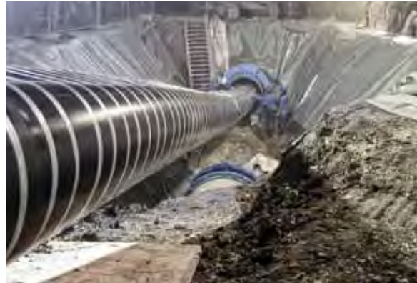
Abb. 21 – Sanierung (Relining): ohne Ringraum (close-fit-lining)
