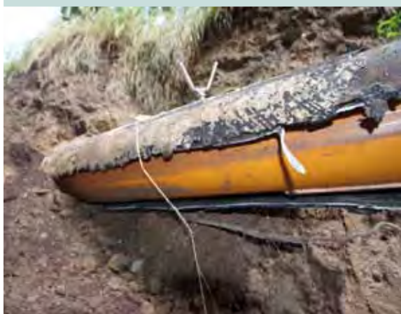
Abb. 1 – Verlegung einer Sureline-Rohrleitung mittels Berstlining
