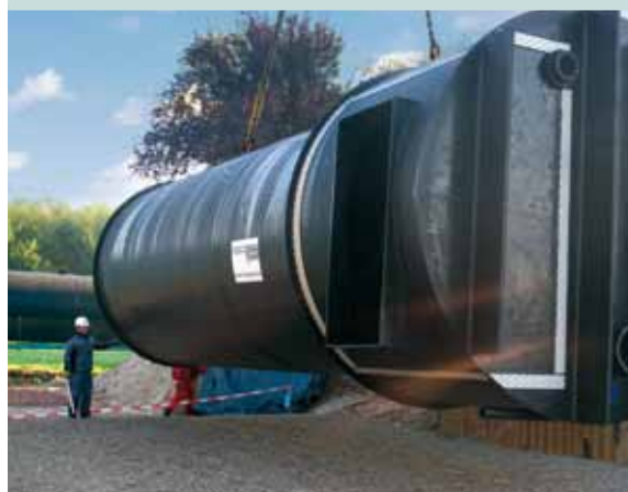
Abb. 2 – Einsetzen eines FTW®-Trinkwasserspeichers
