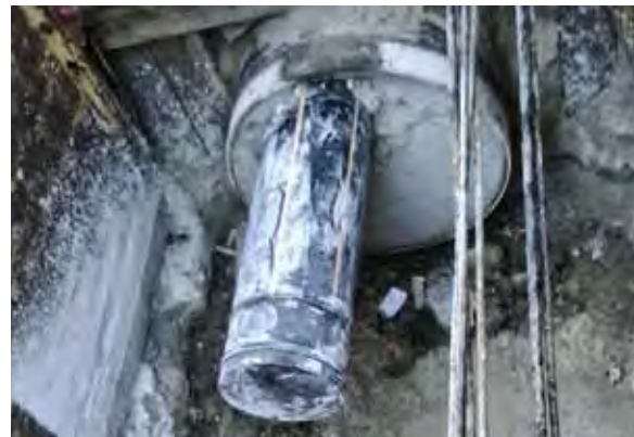
Abb. 23 – Erneuerung (Relining): mit Ringraum und anschließender Verfüllung
