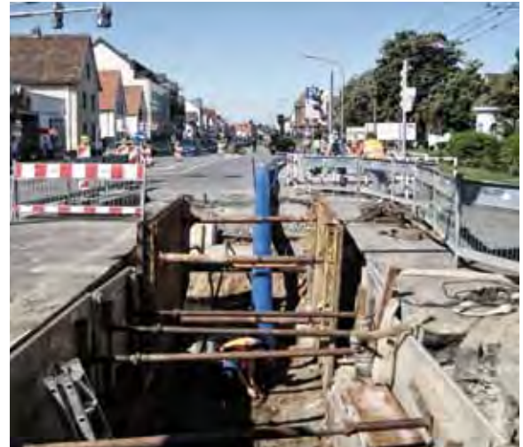
Abb. 19 – Startgrube eines Relining-Projekt mit einem Sureline-Rohr da 160 mm
