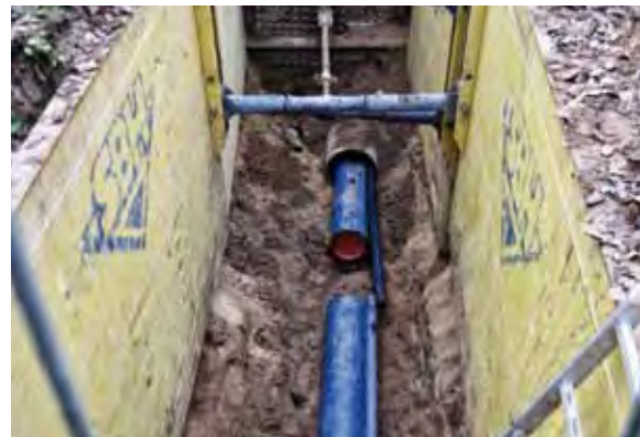
Abb. 22 – Erneuerung (Relining): mit Ringraum
