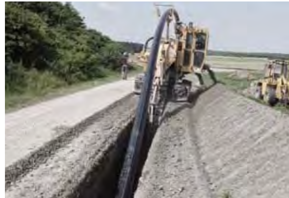
Abb. 27 – Neuverlegung (Fräsen): Verlegevorgang
