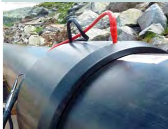
Abb. 4 – Heizwendelschweißung
