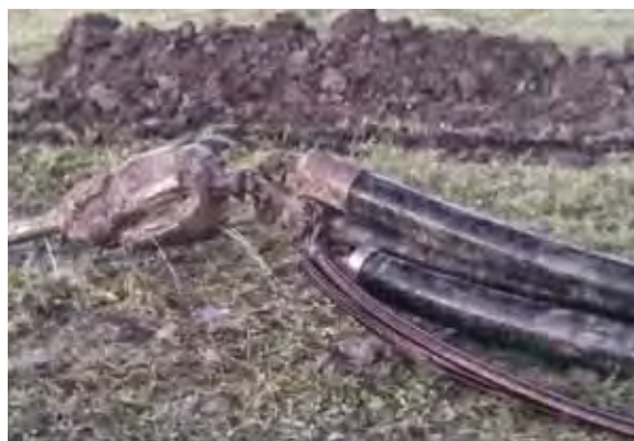
Abb. 29 – Neuverlegung (Horizontalspülbohren): Aufweitkopf mit drei Rohrsträngen
