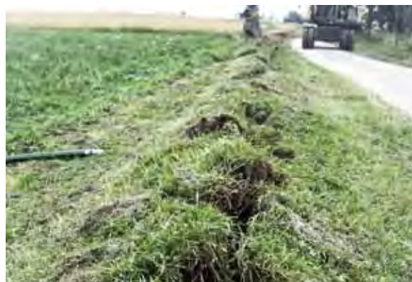
Abb. 25 – Neuverlegung (Pflügen) Geringe Flurschäden
